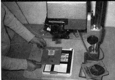
Fig. 10 - Ecco come si pone sulla carta la scala di esposizione Kodak per ingrandimenti. Tutta l'immagine va proiettata sulla scala per un minuto.
