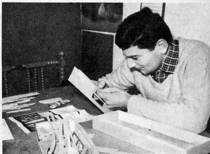
Fig. 1 - Tutte le parti componenti sono tracciate, mediante incisione, su fogli di legno. Per ricavarle basta agire con la sola pressione delle dita.
