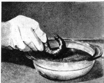
Fig. 4 - L'asciugacapelli si rende molto utile dopo la risciacquatura dell'oggetto; con esso si elimina ogni residuo di umidità dalle superfici metalliche.
