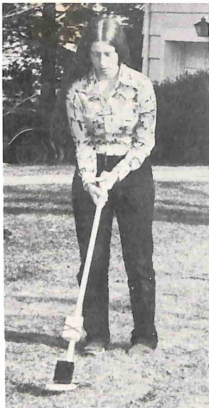
Fig. 2 - Cercametalli semi-giocattolo adatto ai principianti. A fior di terra si nota la "testa esploratrice" che sostiene la bobina sensibile agli eventuali trovati. Nella scatola scura subito sopra, è contenuto l'oscillatore RF di figura 3. Il radiorecettore che manifesta le variazioni del campo elettromagnetico, per essere facilmente recuperabile (non deve essere infatti modificato), è tenuto aderente all'asta lignea di supporto con un semplice elastico incrociato.
