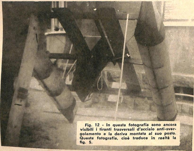
**Fig. 12 - In questa fotografia sono ancora visibili i tiranti trasversali d'acciaio anti-svergolamento e la deriva montata al suo posto. Questa fotografia, cioè traduce in realtà la fig. 5.**
