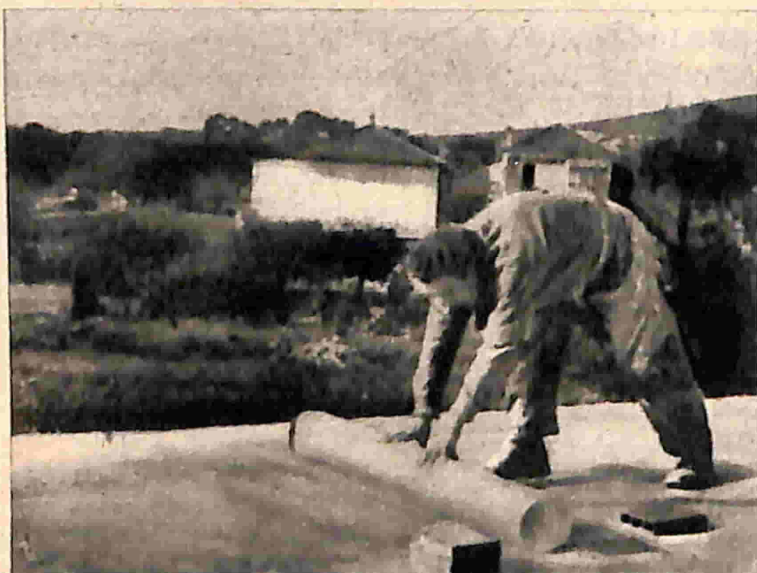
Fig. 2 - Steso uno strato di sabbia fine, srotoleremo il foglio di polyetilene, iniziando dalla parte di livello più basso della terrazza...
