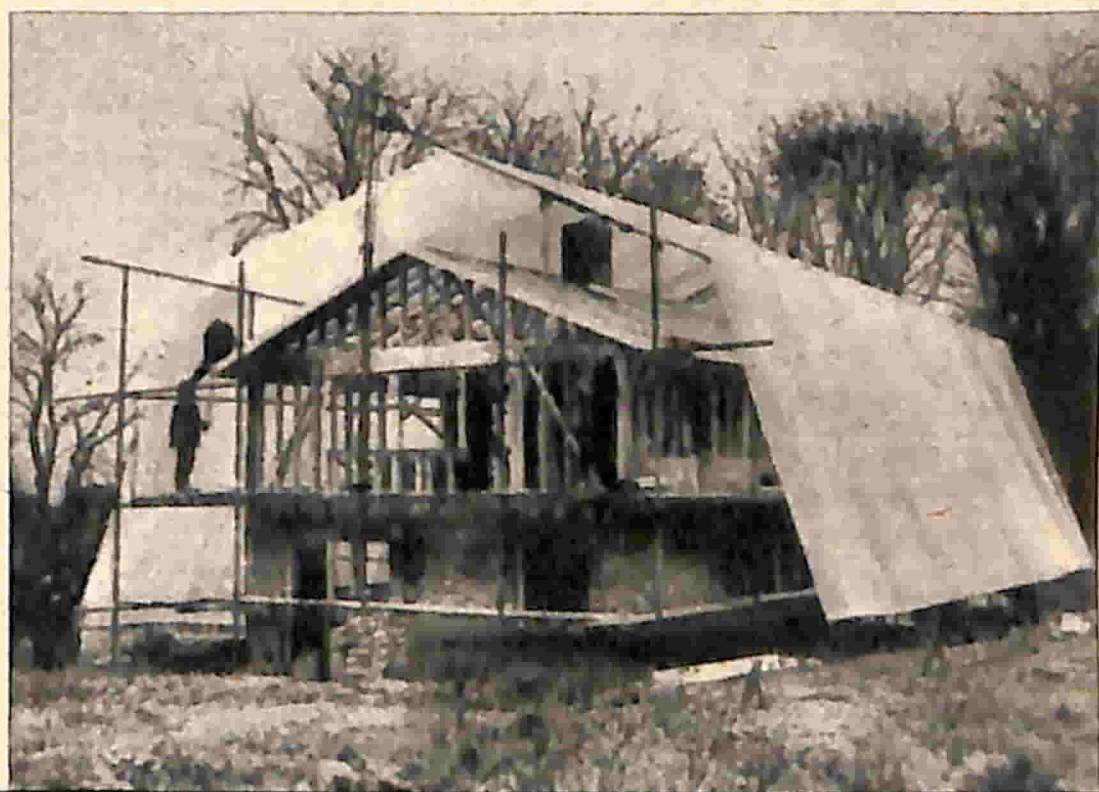
Fig. 4 - Inchiodato su semplici intelaiature in legno, il foglio di polyetilene permette che i lavori di cantiere possano proseguire, grazie alla sua trasparenza, in perfetta luce, proteggendo al tempo stesso uomini e cose dalle probabili intemperie.
