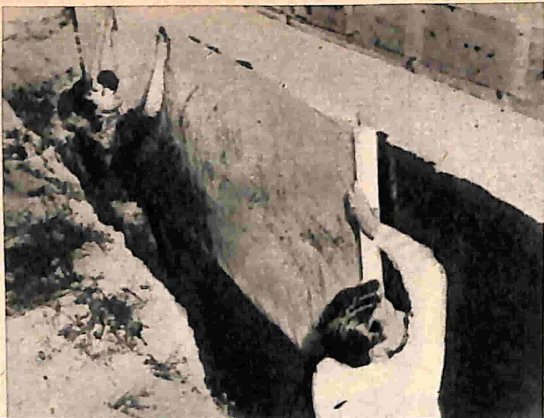
Fig. 1 - Ad evitare infiltrazioni di umidità nelle fondamenta si posano i fogli di polyetilene senza effettuare giunti di copertura. Si ripasserà però con una spazzola al fine di assicurare la perfetta aderenza.
