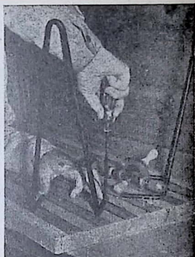
Fig. 3 - Terminato il piano del tavolino si passerà al fissaggio delle gambe, mediante viti a legno.
