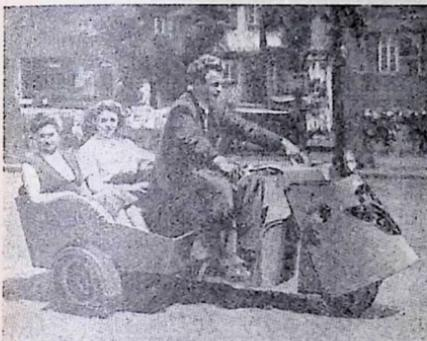
Questo motoscooter che appare ora nelle lontane vie del Pakistan viene costruito in Europa e precisamente in Germania. Il motore costruito in Germania non poteva non essere un due tempi. Le caratteristiche e l'estetica a quanto appare non sono malvagie. Infatti con 200 Kg. di carico può raggiungere una velocità di 75 Km. all'ora.
