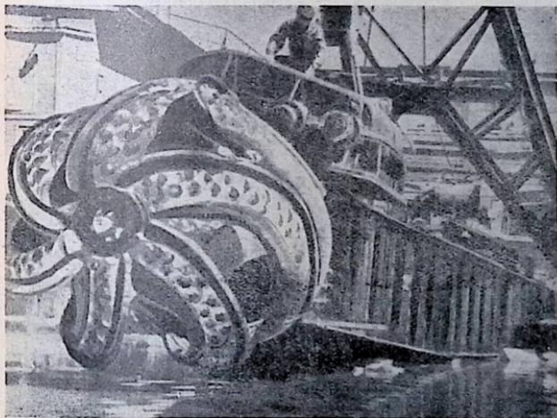
La necessità di scavare giganteschi canali per l'irrigazione del paese, hanno indotto i tecnici dell'URSS a costruire questa gigantesca draga aspiraterra. La terra scavata da questa fresa, viene impastata con l'acqua del canale. La terra mista ad acqua viene poi aspirata da una pompa centrifuga, e gettata sugli argini per elevarli. La fotografia mostra la poderosa fresa capace in un'ora di scavare circa 1000 metri cubi di terra.
