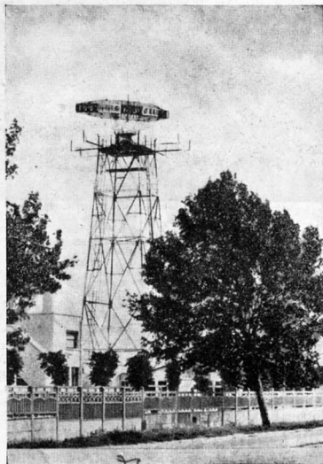
Fig. 2 - Radar terrestre per la sorveglianza a grande distanza. Funziona sulla banda dei 10 cm. e la sua potenza raggiunge i 600 Kilowatt che gli consentono una portata aggirantesi sui 300 Km. Il radar preso in esame risulta installato nel Nord della Francia e viene usato, in tempo di pace, per il controllo del traffico aereo.
