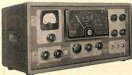
Le operazioni di taratura relative al ricevitore G 207 possono essere suddivise in due fasi ben distinte. Una prima fase si riferisce alla taratura dei due canali di Media Frequenza, dello stadio discriminatore NBFM e della regolazione della nota di battimento per la ricezione della telegrafia non modulata.
