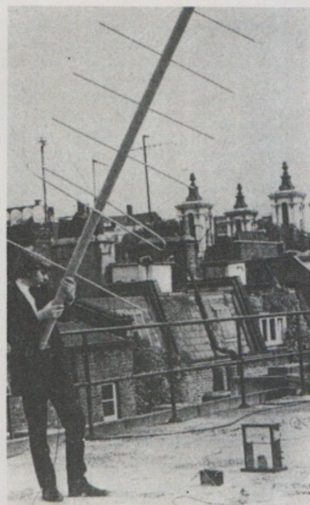
Fig. 14 - L'antenna e l'S-Meter. Il cavo coassiale si porta alla scatola di alluminio che contiene il ricevitore. La scatola nera contiene il primo amplificatore audio e l'altoparlante di controllo.
