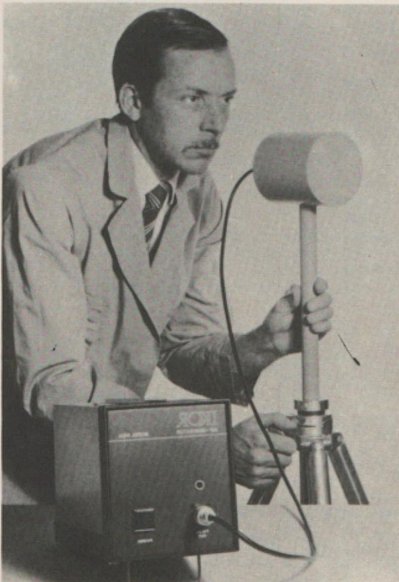
Fig. 4 - Il generatore di impulsi Ikor è uno strumento leggero e compatto, alla cui uscita viene collegato un trasduttore tramite il quale vengono irradiati i segnali necessari per effettuare i rilevamenti consentiti.
